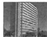
Édifice La Tourelle (Montréal)
